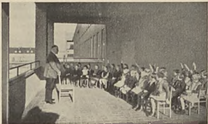
Rys. 80. Klasa na werandzie w szkole pod Dreznem (z „Der neue Schulbau”).
