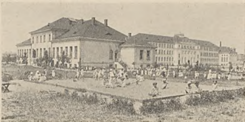
Rys. 340. Przedszkole t. zw. „tramwajowe” w Warszawie przy ul. Młynarskiej. Piaskarnia.
