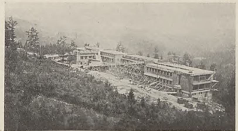
Rys. 235. Uzdrowisko z pawilonem szkolnym w Istebnej (Śląsk Cieszyński). Stan robót w r. 1932.
