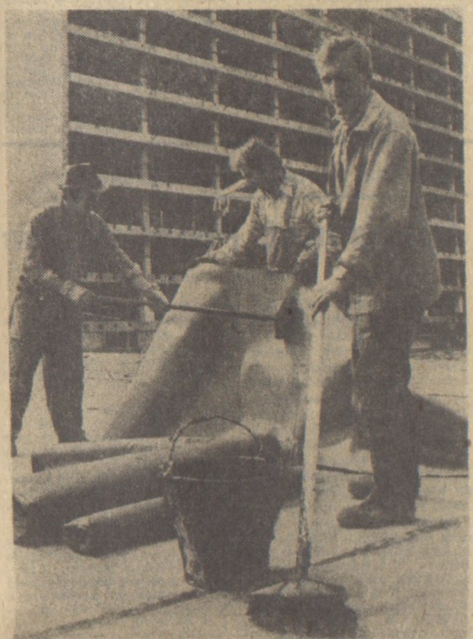
Na budowie Biblioteki Narodowej. Dobiega końca budowa wysokiego budynku Biblioteki Narodowej wznoszonej na warszawskim Polu Mokotowskim. Fot. CAF — Broniarek
