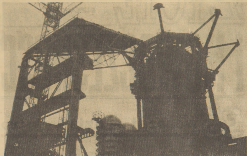
Budowa dużej, nowoczesnej huty stała się koniecznością
