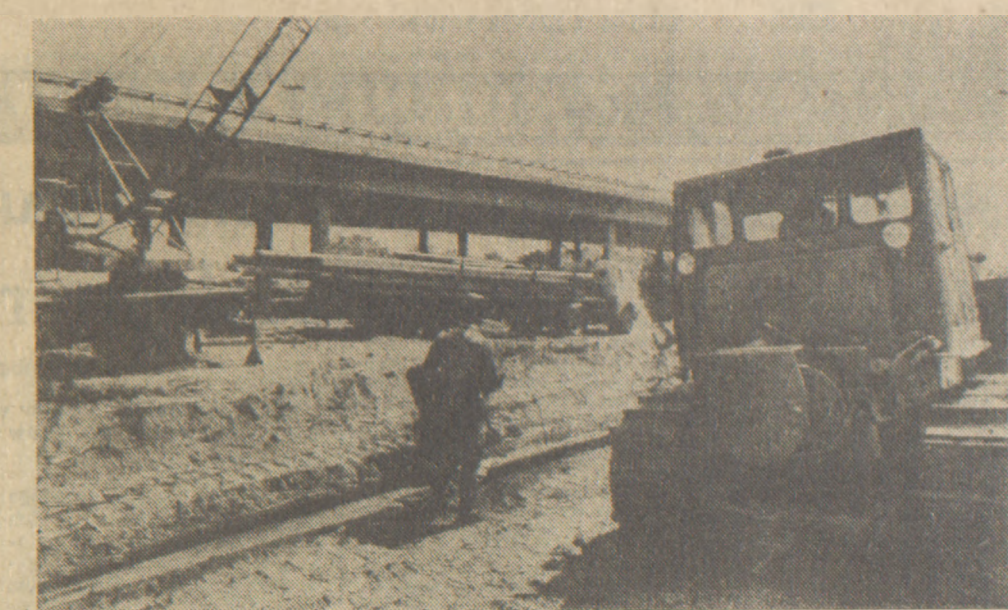
Modernizacja ul. Modlińskiej w Warszawie i przekształcenie jej w nowoczesną dwupasmową arterię szybkiego ruchu zbliża się ku końcowi. Przy budowie pomagają w ramach szkolenia m.in. żołnierze z jednostki wojsk kolejowo-drogowych, którzy obecnie uprzątają teren pod wybudowanym już wiaduktem Trasy Modlińskiej nad ul. Płochocinską.
