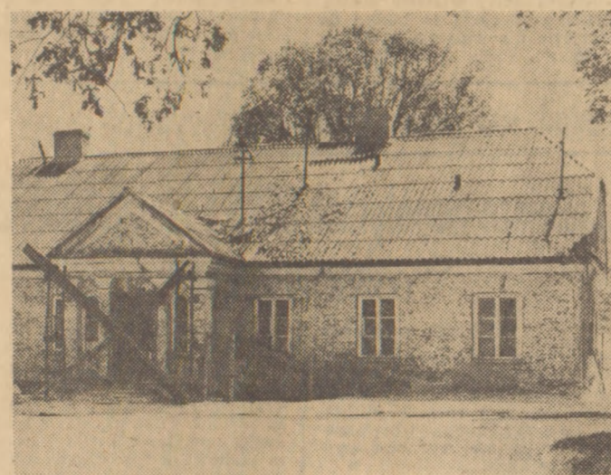
XIX-wieczny dworek jest pieczęlowicie remontowany.
