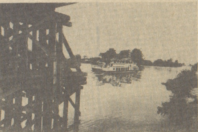
(P) Przez cały czas budowy mostu utrzymywana była żegluga na Odrze.
