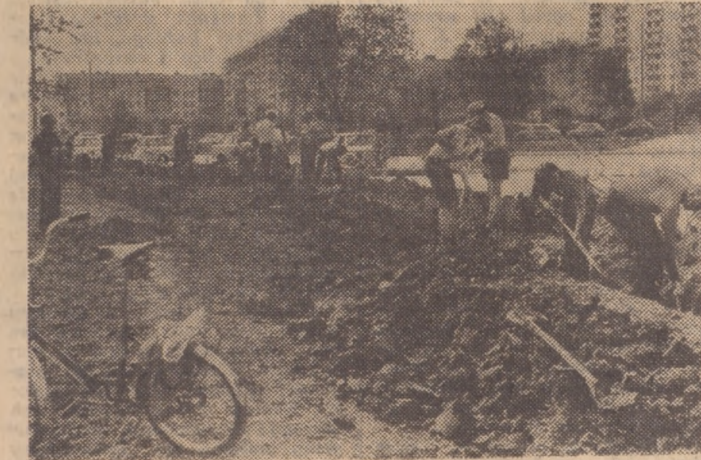
Przy ul. Południowej robiono wykop pod kabel — bardzo trudna to i specjalistyczna praca wymagająca siły i fachowości
