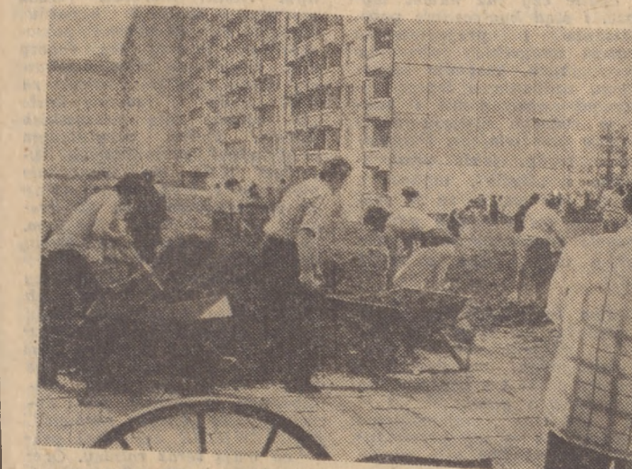
Na nowych osiedlach trwała praca tuż przed blokami. W niedzielny Czynie często indywidualni mieszkańcy przyłączali się do pracujących tam grup. Fot. Bronisław Duda
