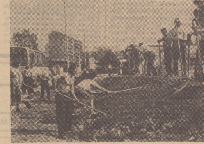
Choć pomagał sprzęt zmechanizowany, ale przy pracach wykonawczych nieodzowne były ludzkie ręce — łopatami, grabkami profilowano skarpy i pasy zieleni przygotowując teren do zasiań trawy
