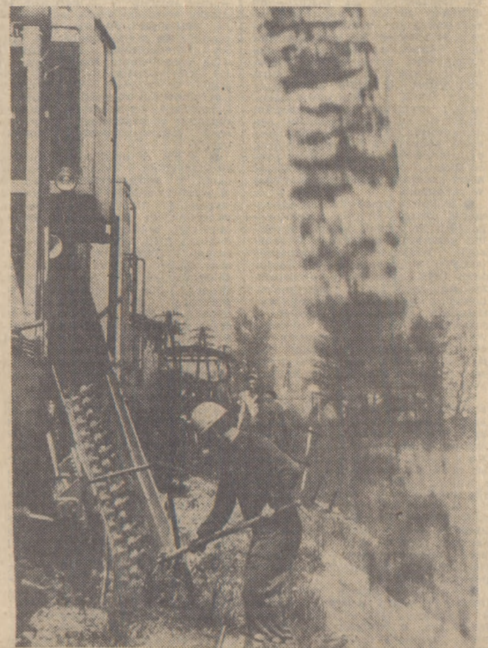
(P) Prace przy modernizacji i wymianie podsypek na torach kolejowych na trasie Jasło — Rzeszów. CAF—Kwiatkowski
