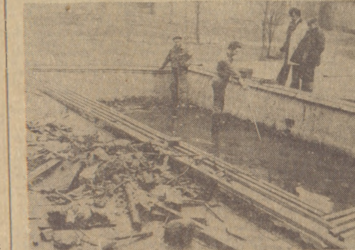
W takim oto stanie był budozisk osiedlowy wśród wieżowców, u zbiegu ulic 1 Maja i Kelles-Krauz
