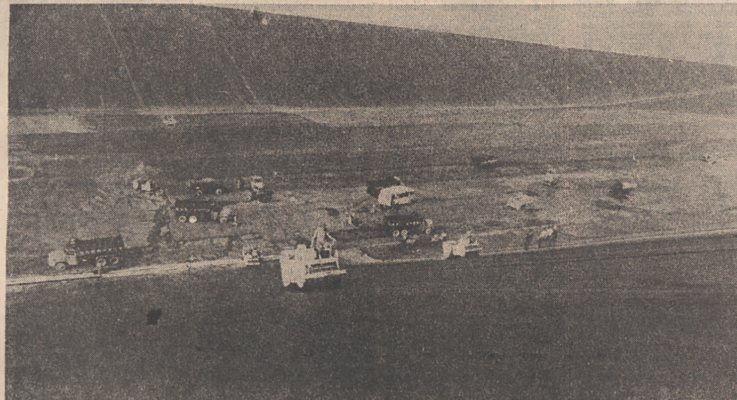
Elektrownia „Porąbka — Żar”. Dobiegają końca prace przy głównym zbiorniku w tej elektrowni szczytowo-pompowej. Wkrótce zostanie on napełniony wodą. W tym roku przewiduje się oddanie dwóch turbinospółdów o mocy 125 MW każdy. Fot. CAF — Nawot
