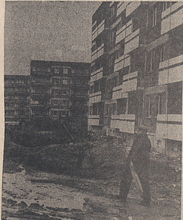
Osiedle „Chemik” w budowie
