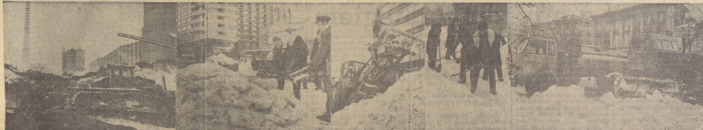
Na składowiskach węgla, ulicach, placach, do akcji włączono ciężki sprzęt. W elektrociepłowni Stokierki spychacze rozbiły zamrożone hałdy opalu i przesuwają go pod taśmociąg. Ciężarówki, traktory i ciągniki gąsienicowe i pługami usuwały zasypy śnieżne, zdarzają łód z jezdní, oczyszczają tory. Duże ilości sprzętu — spychaczy i ładowarek — dostarczyły przedsiębiorstwa budowlane, zakłady przemysłowe i wojsko.
