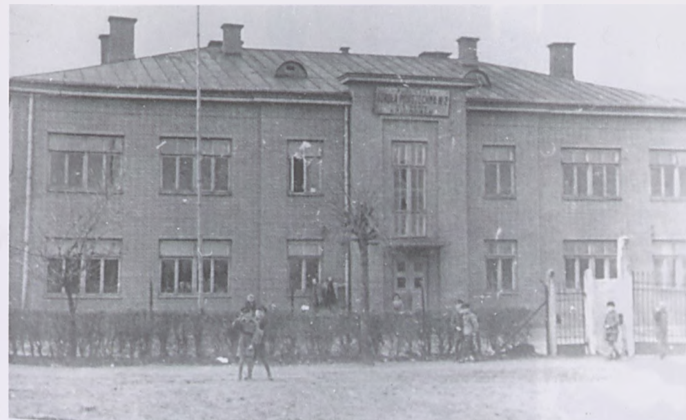
Budynek Liceum i Szkoły Podstawowej nr 2 przy ul. Kochanowskiego 8. Stan z 1951 r. Fot. ze zb. W. Trysińskiego.
