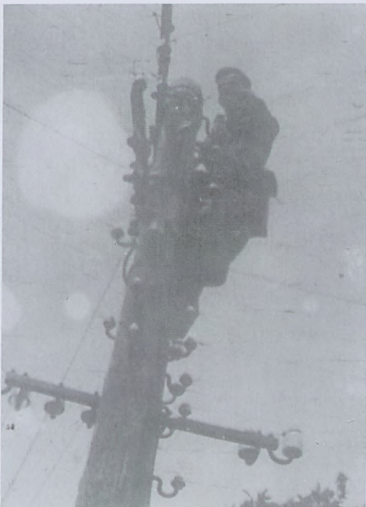
Marian Wiktorowski przy wykonywaniu pracy elektryka. Fot. ze zb. M. Wiktorowskiego.
