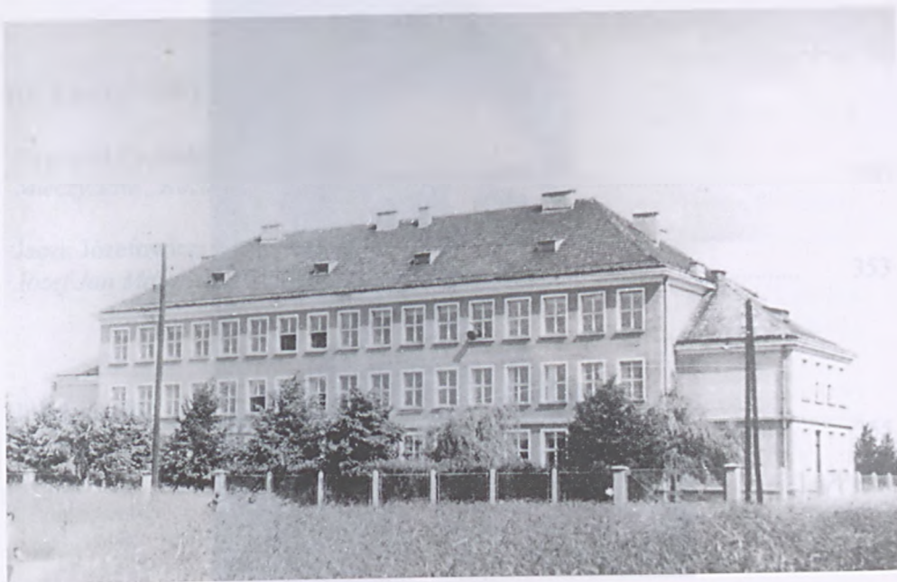
Nowy budynek szkolny oddany do użytku w 1955 r. Stan z 1962 r. Fot. ze zb. W. Trysińskiego.
