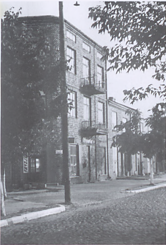
Kamienica przy ulicy Kolejowej. Lata 60-te. Fot. ze zbiorów Jana Banaszaka.
