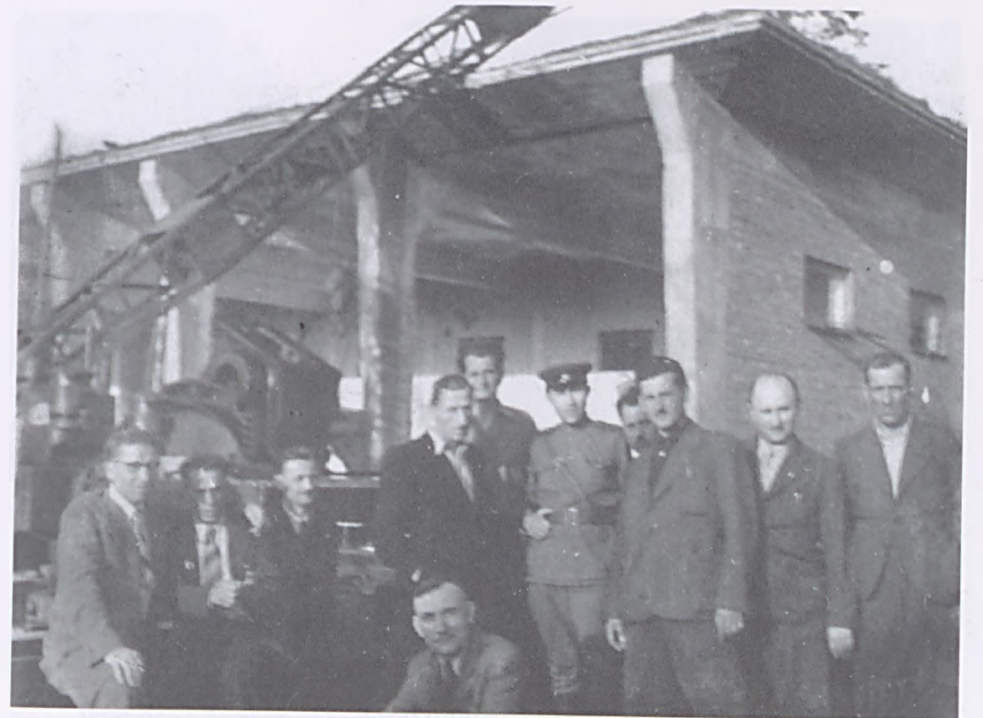
Ekipa przy dźwigu. Niemcy 1946 rok. Fot. ze zbiorów Adolfa Misiuny.
