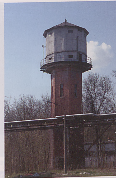
Zakład (Wydział) „PA”. Budynek BS-17 „wieża ciśnień”. Foto ze zbiorów Jarosława Szczypiora.
