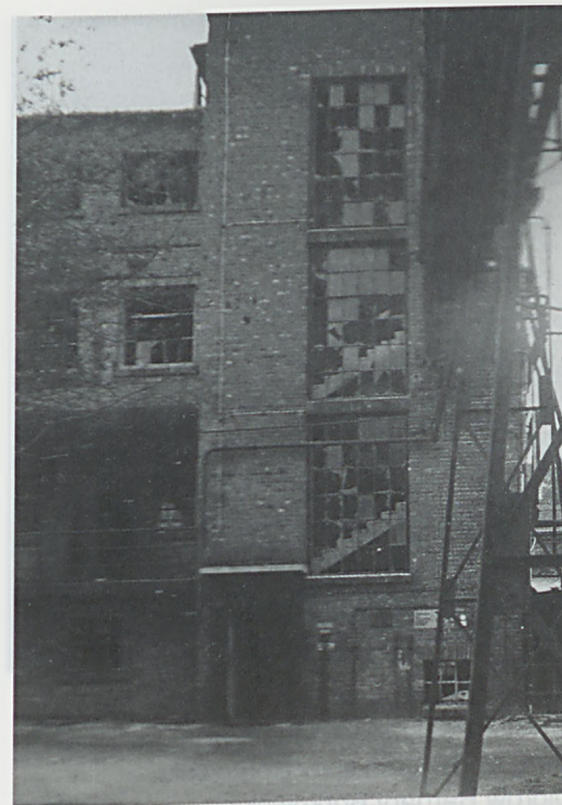
Zakład (Wydział) „PA” ZTS „Pronit”. Budynek produkcyjny po wybuchu. Lata siedemdziesiąte. Foto ze zbiorów Jarosława Szczypiora.
