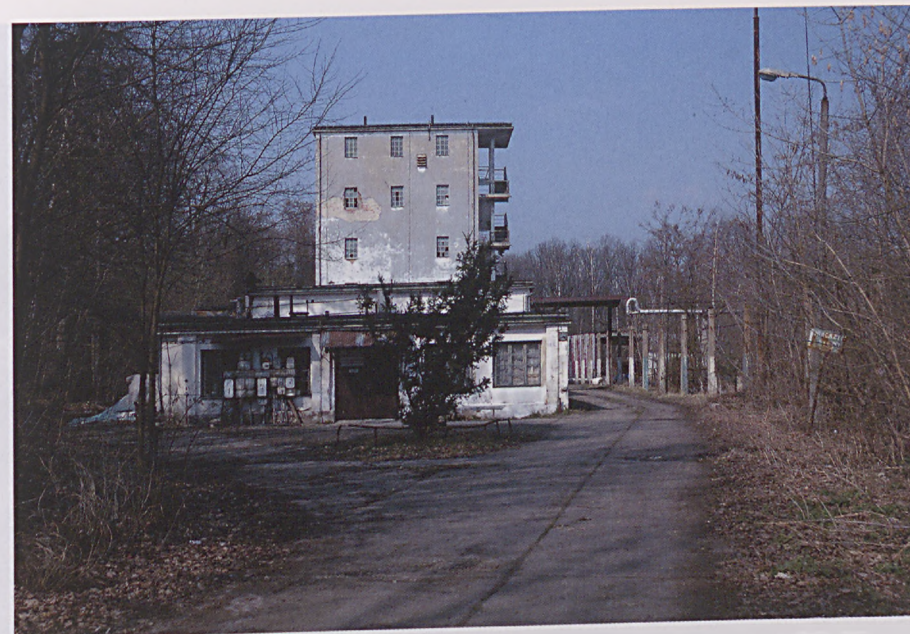
Zakład (Wydział) „PA”. Budynek produkcji klejów emulsyjnych BS-28. Rok budowy 1960. Foto ze zbiorów Jarosława Szczypiora.
