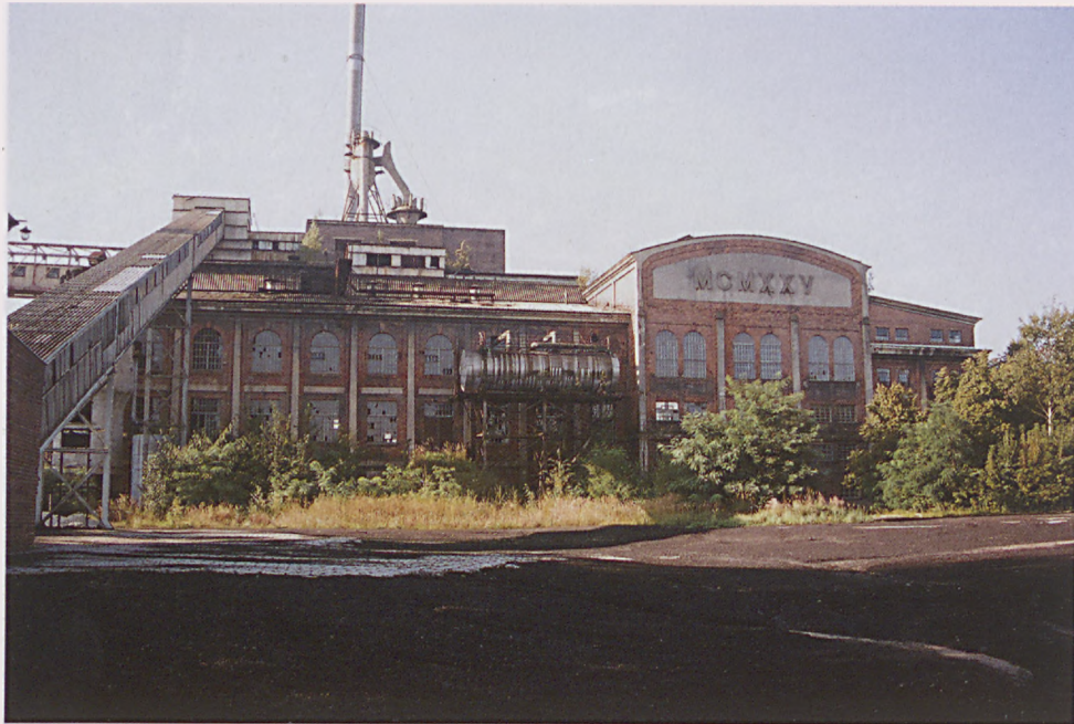
Rejon Centralny. Budynek elektrowni. Foto ze zbiorów Jarosława Szczypiora.
