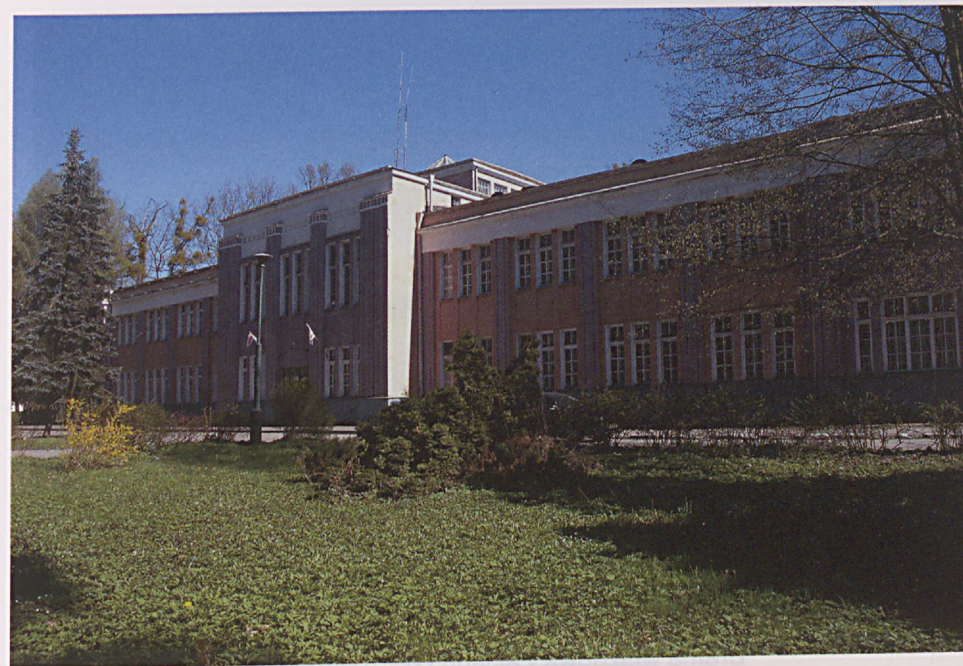
Budynek Dyrekcji ZTS „Pronit”. Foto ze zbiorów Jarosława Szczypiora.
