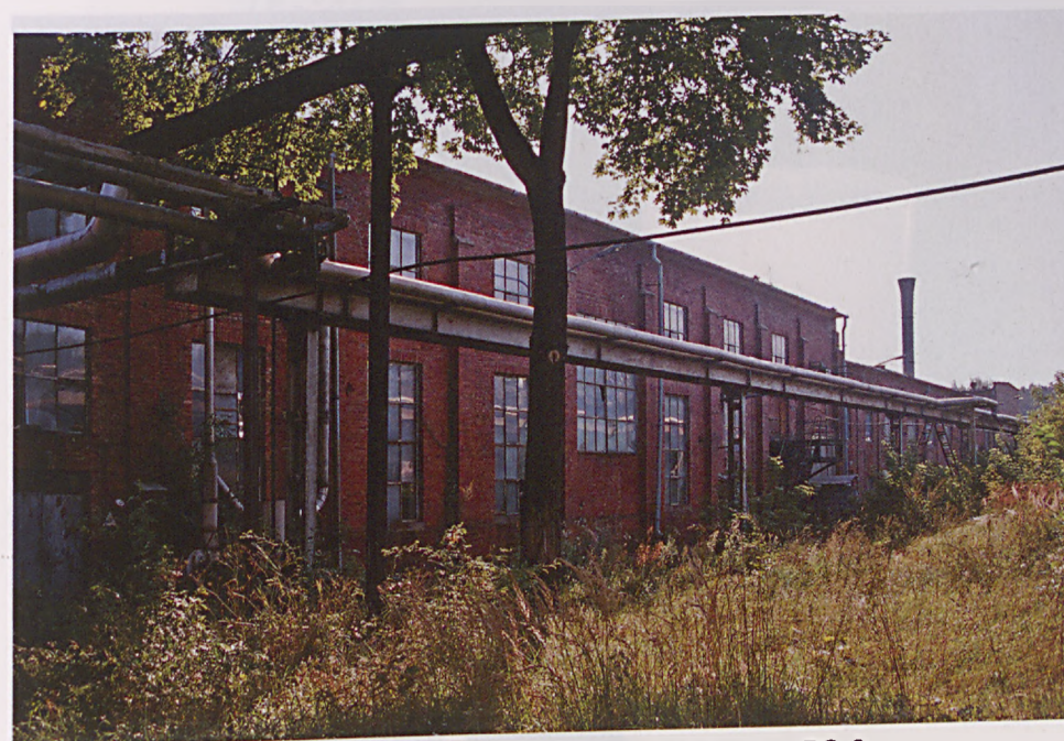
Zakład (Wydział) „PA”. Budynek produkcyjny BS-9. Foto ze zbiorów Jarosława Szczypiora.
