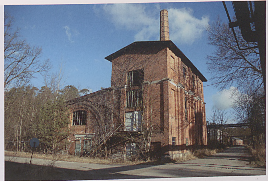
Zakład (Wydział) „PL” („FAM”). Budynek D-3 kotłowni „FAM”. Foto ze zbiorów Jarosława Szczypiora.
