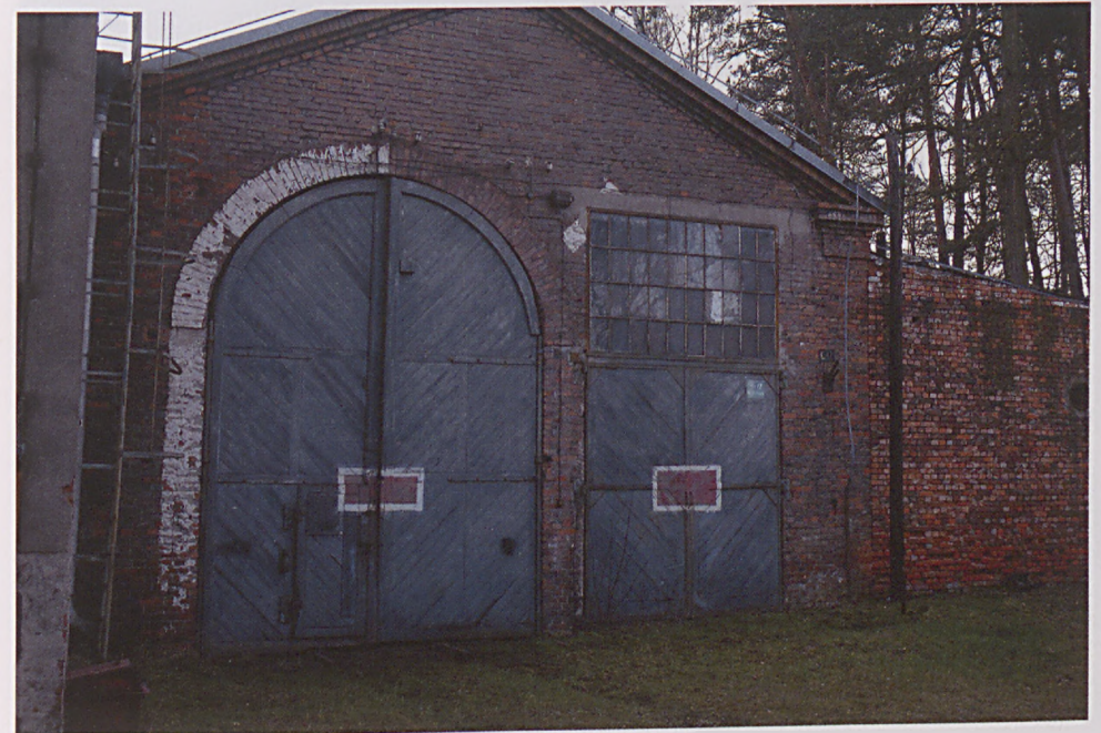
Rejon Centralny. Parowozownia. Foto ze zbiorów Jarosława Szczypiora.
