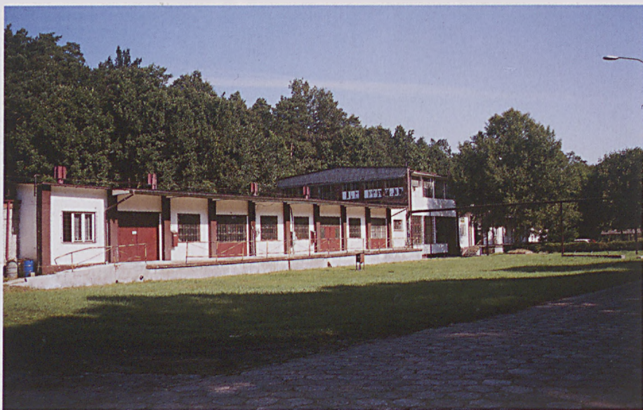
Budynek Wydziału E-2. Foto ze zbiorów Jarosława Szczypiora.
