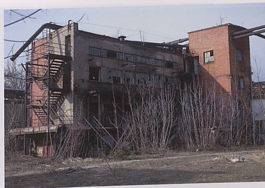
Zakład (Wydział) „PA”. Budynek BS-15 „stara nitracja”. Rok budowy 1928. Foto ze zbiorów Jarosława Szczypiora.
