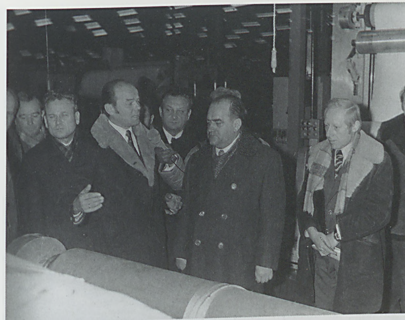
Wizyta wicepremiera Franciszka Kaima na terenie budowy WSS „Polcorfam”. Pionki, 20 września 1972 r. Foto ze zbiorów Michała Borocho.
