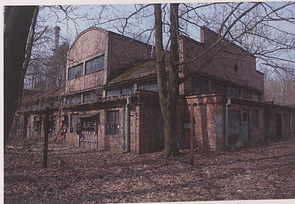
Zakład (Wydział) „PA”. Budynek produkcji celulozoidu. Foto ze zbiorów Jarosława Szczypiora.
