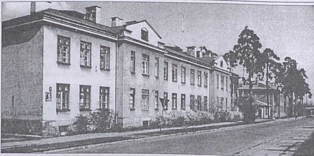
6. Domy robotnicze na Nowej Kolonii w Zagórzdonie - Pionkach, wybudowane w 1929 roku według projektów Jana Kałaski, wykonane pod kierunkiem inż. arch. Eugeniusza Czyży, w Biurze Konstrucyjnym PWP. Tytuł projektu: "Dom robotniczy M 93 na 16 mieszkań po 1 pokoju z kuchnią i 4 pokoje zapasowe od ul. Orzeszkowej 5". Fot. B. Blum.
