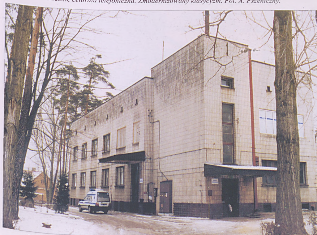
Szpital wojskowy w Pionkach (ok. 1936). Autor planów niezany. Nad wejściami daszki szklane przerobiono na stalowo-drewniane, w latach siedemdziesiątych. Obiekt rozbudowany. Część główna bez zmian. Przykład architektury funkcjonalnej określanej jako piękno utylitarne. Zdjęcie - luty 2000 roku. Fot. A. Pszeniczny.
