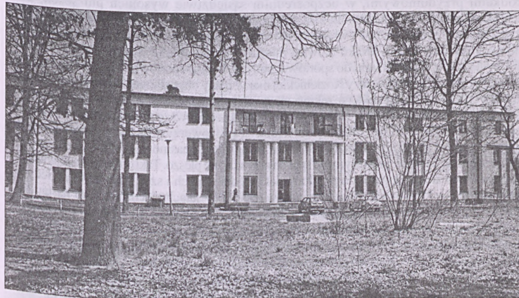
30. Koszary dla 80 wartowników Straży Bezpieczeństwa Wytwórni. 1930 rok, arch. E. Czyż. Elewacja frontowa. Zdjęcie z 1993 roku. Dziś przed frontem stoją garaże. Fot. B. Blum.
