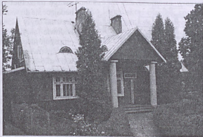
8. Plebania przy kościele św. Barbary w Pionkach (1933) według projektu domku robotniczego M 15. Projektowała Jaworska. Ryc. 7 i 8 - przykłady architektury dworskiej. Zdjęcie - czerwiec 1994 roku. Fot. B. Blum.
