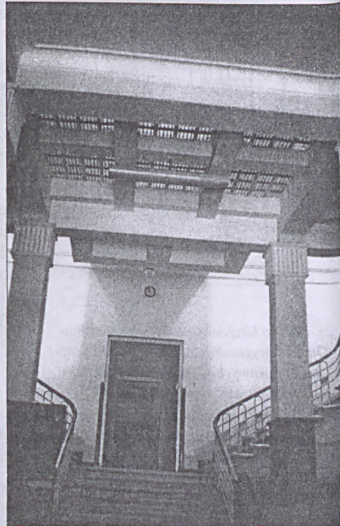
29. Biura Główne PWP. Klatka schodowa w hallu głównym, podesty szklano-żelbetowe, zachowane do dziś. Przykład pionierskiej myśli konstrukcyjnej i doskonałego wykonawstwa. Zdjęcie - czerwiec 1994 roku. Fot. B. Blum.
