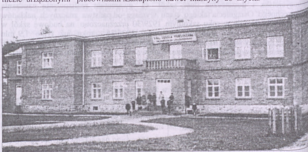
Budynek Publicznej Szkoły Doksztalcącej Zawodowej przy PWP w Pionkach ul. Kolejowa. Lata trzydzieste. Fotografia ze zbiorów Jana Włodarczyka.
