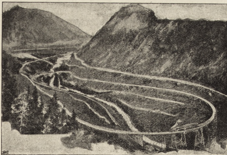
Wężowe pętlice („Loop“) na kolei oceanu Spokojnego.
