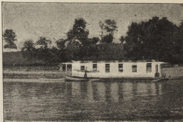
Widok stacji pływającej.
