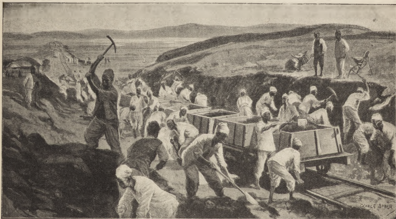
Budowa kolei żelaznej z Seoulu do Fusanu.
