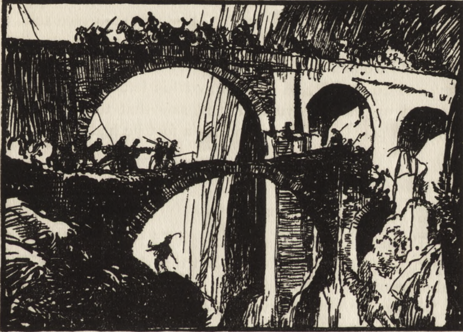
PONT DU DIABLE, ST. GOTHARD PASS
