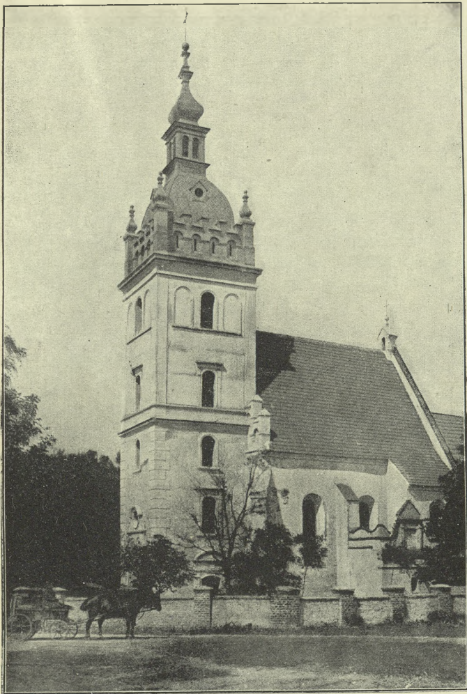
Fig. 8. Kościół paraf. w Chojnem, po przebudowie wieży. Przykład ujemny.
