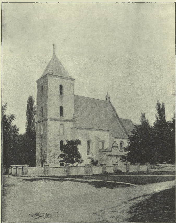
Fig. 7. Kościół paraf. w Chojnem przed przebudową wieży.
