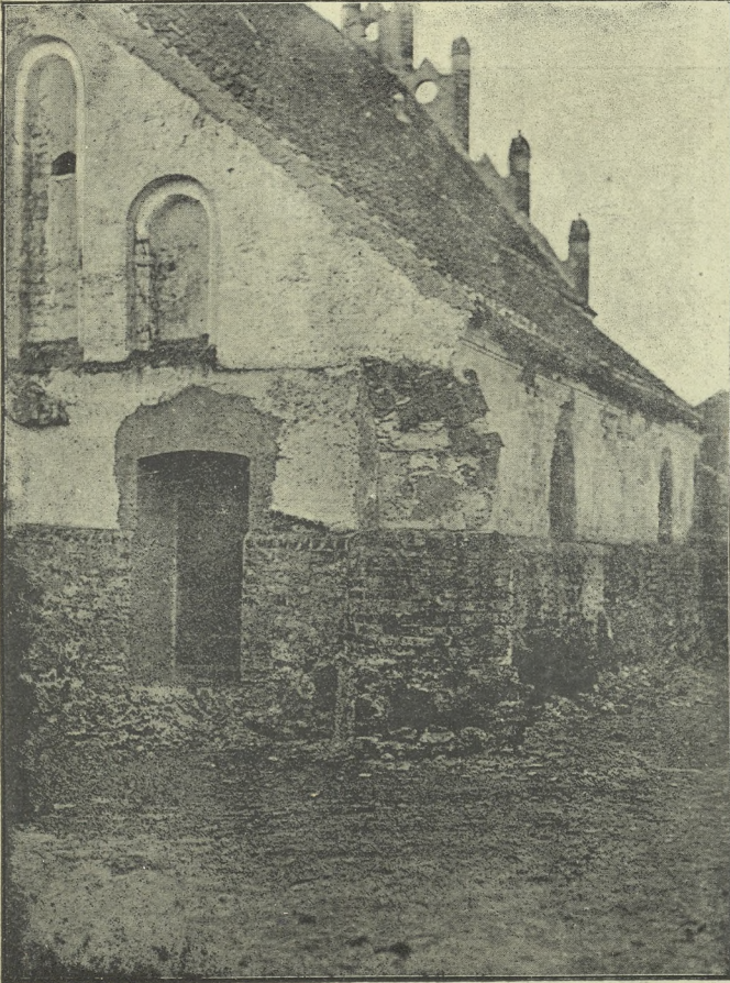
Fig. 22. Zakrystja przy kościele paraf. w Bożewie po przebicu nowych otworów. Przykład ujemny.
