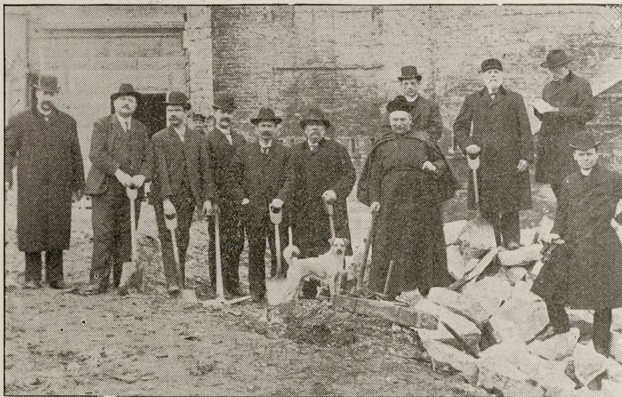
ZAKŁADANIE FUNDAMENTÓW POD SZKOŁĘ ŚW. STANISŁAWA KOSTKI W CHICAGO.
