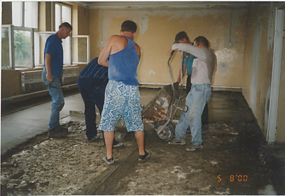
Wylewka betonu pod podłogę w stowej sali gimnastycznej
