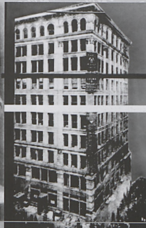
Na zdjęciu: od lewej - Isaac Harris i Max Blanck właściele Triangle Shirtwaist Factory po wyjściu z sądu. Obok budynek Triangle Shirtwaist Factory zaraz po pożarze. Gruba biała linia pokazuje, do którego piętra kamienicy sięgały najdłuższe drabiny nowojorskiej straży pożarnej, których w 1911 r. było aż ...siedem.
