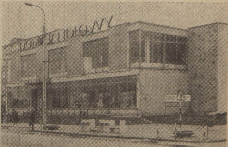
Takich obiektów wybudowano w Kozienicach niewiele.
