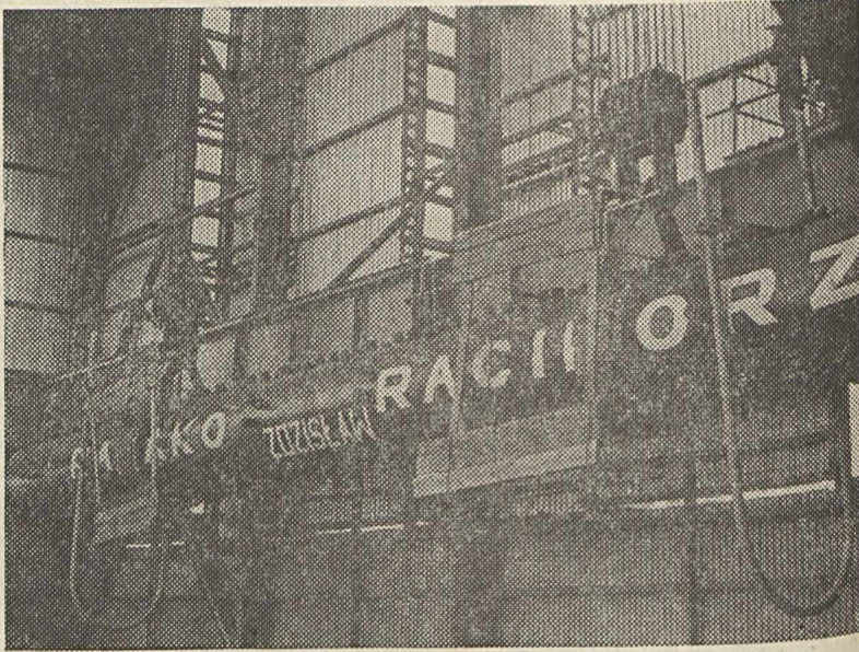
Zakładanie wciągu linowego na poziomie 33 m.
