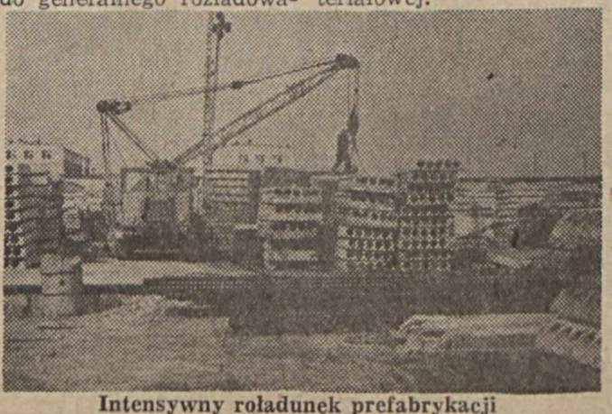
Intensywny rozładunek prefabrykacji
