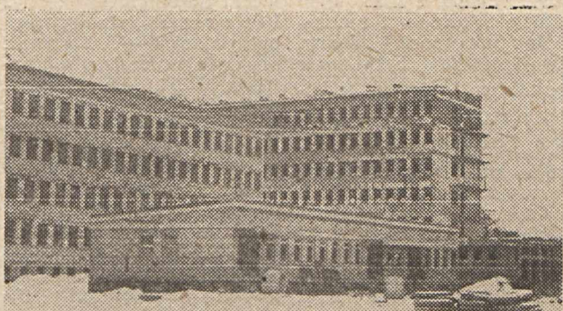
Budynek Główny Szpitala i Przychodnia w stanie surowym. Teraz czeka budowlanych trudna wykończeniówka.
