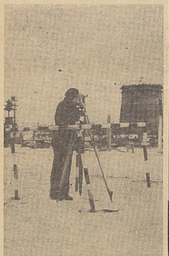
Na budowie trzeciego etapu. Geodeci przy pracy.
