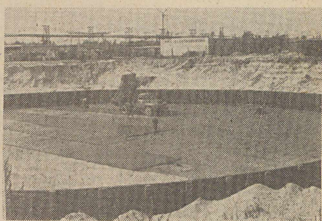
Płyta pod komin bloków 500 MW Foto: J. Wojtkowski
