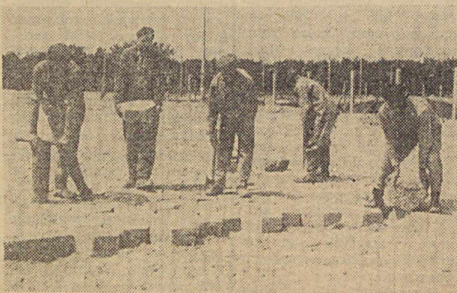
Brygada Zbigniewa Kowalskiego układa trelinę na stanowiskach dla autobusów.
