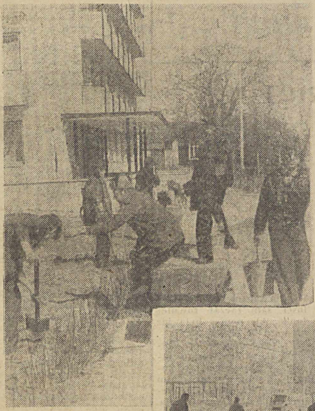
Porządkowanie terenu wokół hotelu „Energetyk”
