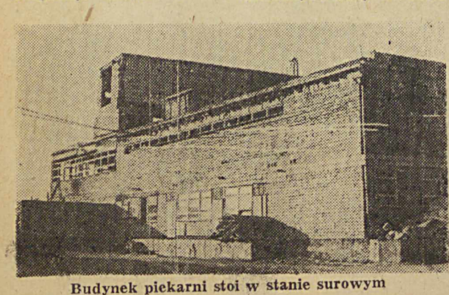
Budynek piekarni stoi w stanie surowym
