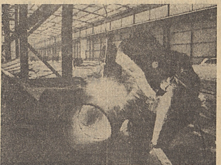
(P) Pracownicy plockiego „Instalu” montują stalowe konstrukcje. Fot. CAF — Walczak
