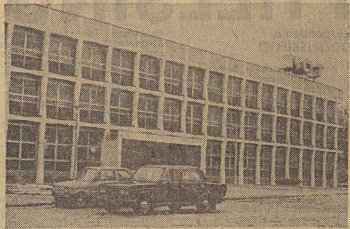
Przy ul. Struga 7a stanął Dom Technika wg projektu mgr inż. arch. Tadeusza Derlatki
