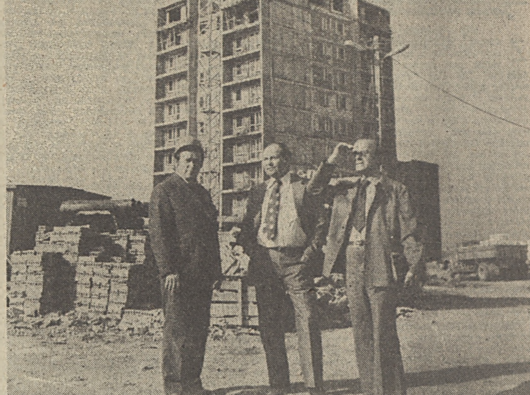
Minister Romuald Kozakiewicz (w środku) na budowie osiedla Zagórze.
