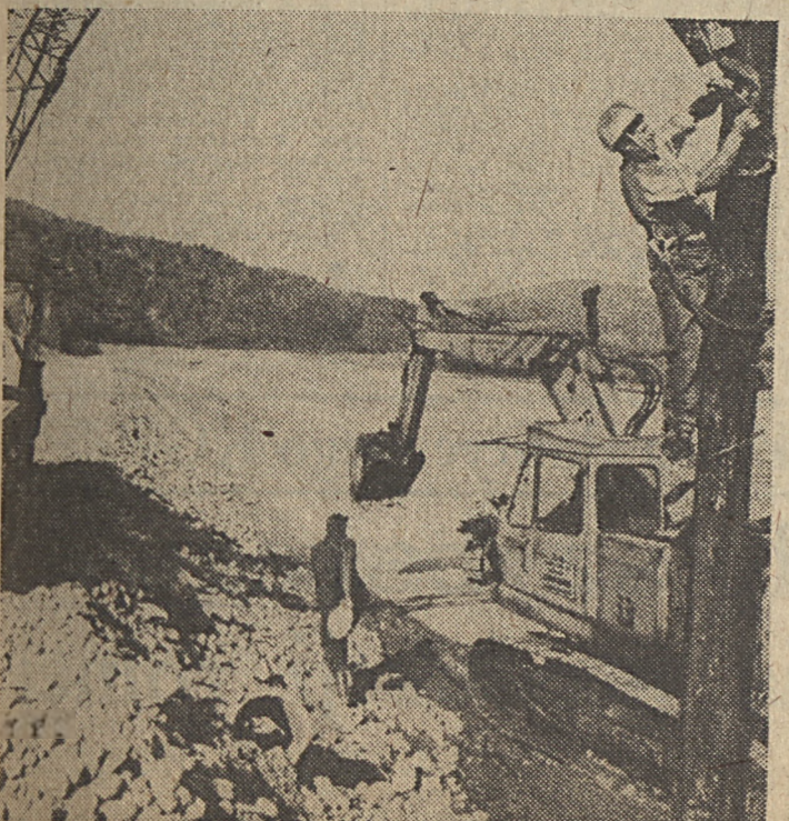
Przebudowa drogi. Do wyjątkowo atrakcyjnych widokowo dróg należy trasa wiodąca wzdłuż Dunajca ze Szczawnicy do Nowego Sącza. Na zdjęciu: przebudowa odcinka w okolicy wsi Tyłmanowa. Tutaj droga wejdzie w koryto Dunajca. Brygada krakowskiego „Energopolu” II budoje mur oporowy. (P)
