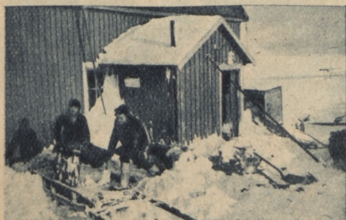
PRZY BUDOWIE DOMKU
