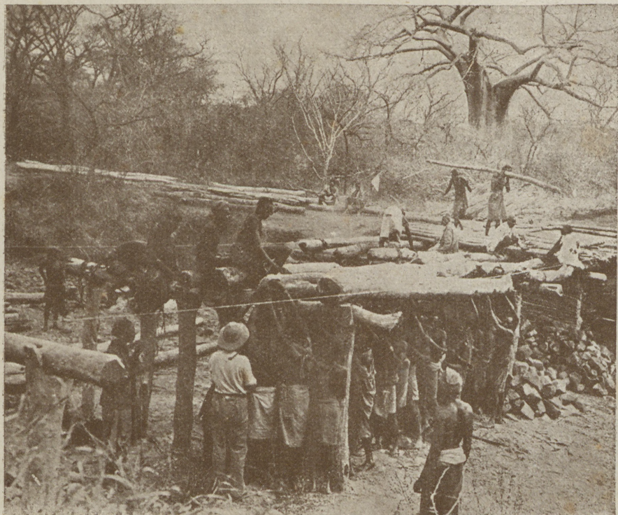
MURZYNI BUDUJĄ MOST NAD ŁOŻYSKIEM WYSCHNIĘTEJ RZEKI.
