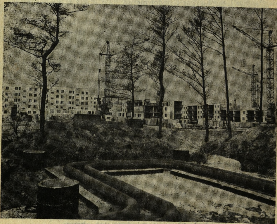
Osiedle „Michałów” w Radomiu w budowie
