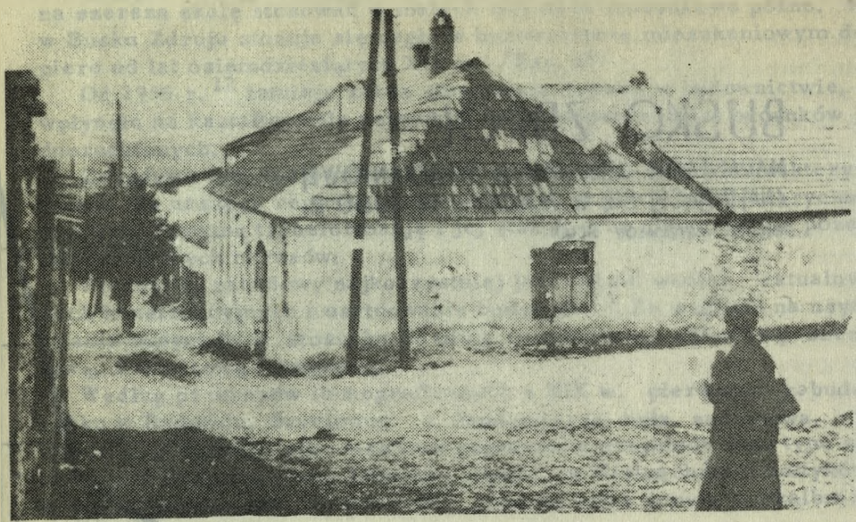
Ryc. 49. Chęciny. Dom zw. "Kamiszarówką". Budynek typu kalenicowego.
