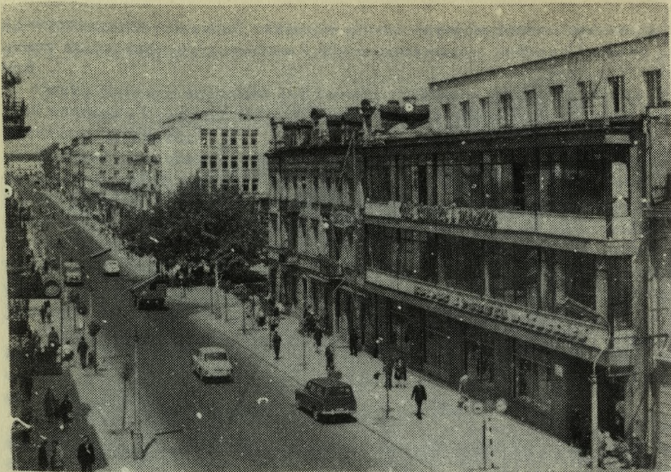
Ryc. 42. Kielce, ul. Sienkiewicza. Wielokondygnacyjna zabudowa śródmiejska. Widoczna przebudowa w różnych okresach i stylach. Fot. T. Hermańczyk.
