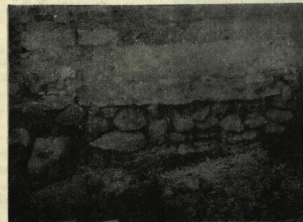
Ryc. 6. Fragment fundamentu ściany południowej odsłonięty w wykopie nr 7. Fot. W. Stan, 1966 r.
