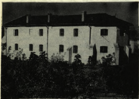
Ryc. 2. Widok ogólny budynku dawnego kościoła św. Wacława od strony południowej przed zbiciem tynków.
