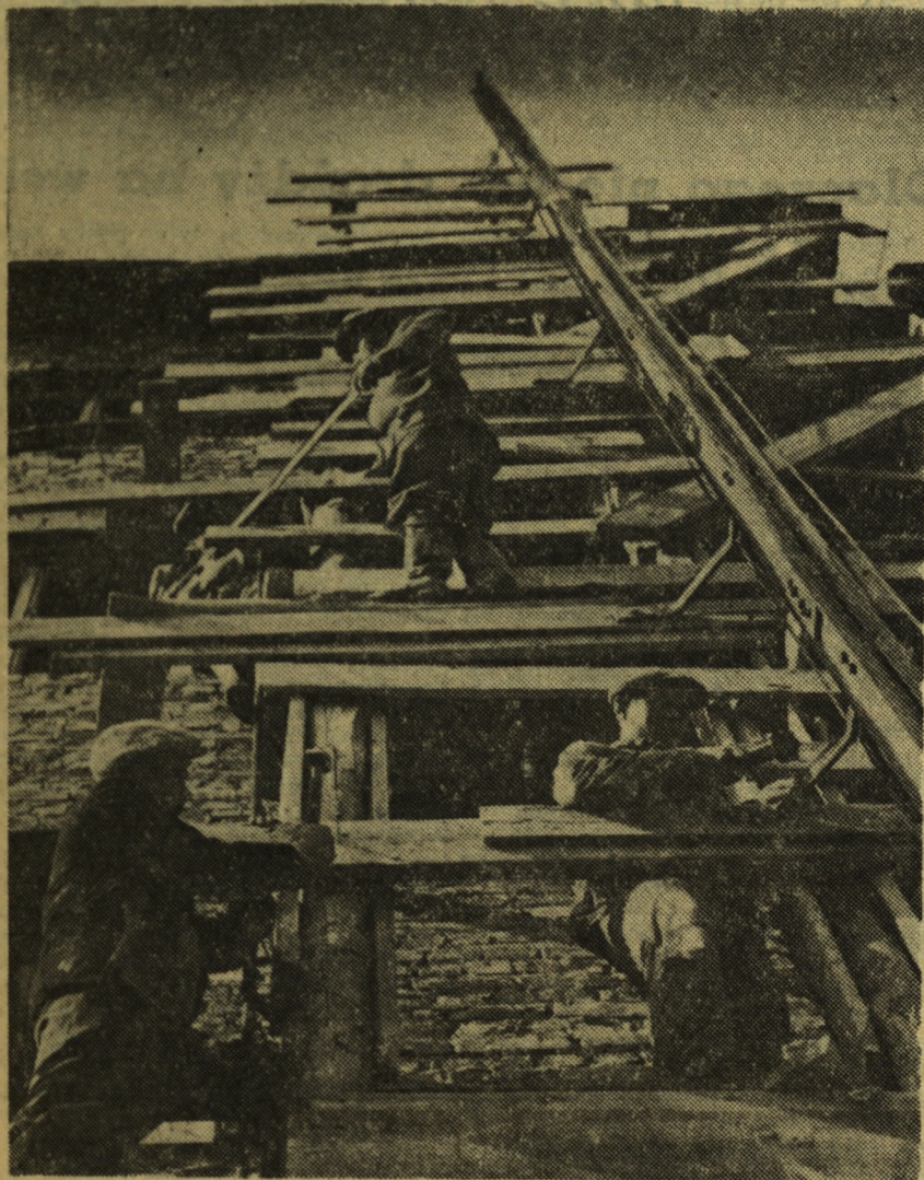
Brigada ciesielska Bronisława Lachowoskiego zaciągnięta na budowie w Radomiu Wartę Październikową świętując swoją wydajność z 280 na 380 proc. Na zdjęciu: brigadziści ze swym zespołem na rusztowaniach.
