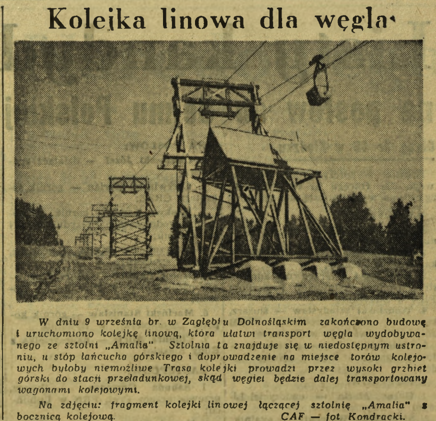
W dniu 9 września br. w Zagłębiu Dolnośląskim zakończono budowę i uruchomiono kolejkę linową, która ułatwi transport węgla wydobywanego ze sztolni „Amalia”. Sztolnia ta znajduje się w niedostępnym ustroniu, u stóp łańcucha górskiego i doprowadzenie na miejsce torów wydobywanych byłoby niemożliwe. Trasa kolejki prowadzi przez wysoki grzbiet górski do stacji przeładunkowej, skąd węgiel będzie dalej transportowany wagonami kolejowymi. Na zdjęciu: fragment kolejki linowej łączącej sztolnię „Amalia” z bocznica kolejową. CAF — fot. Kondracki.
