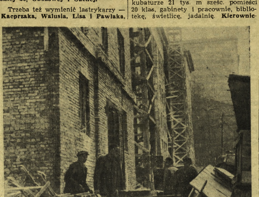
Jedną z czterech szkół, w których 1 września b.r. po raz pierwszy zasiadą uczniowie w nowych klasach, będzie budynek przy ul. Mokotowskiej, na terenie MDM. Na zdjęciu: fragment elewacji frontowej tego gmachu (do art. obok).
