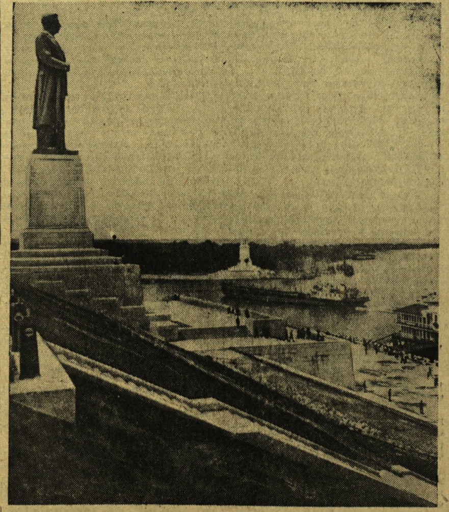
Pomnik Stalina u wejścia do kanału Wotga — Don im. Lenina. Hydroelektrownie tego kanału dostarczą ogromne ilości energii i przyczynią się do zrealizowania wielkich planów V Pięciolatki ZSRR, której projekt będzie rozpatrzony na XIX Zjeździe WKP(b) w dn. 5 października.
