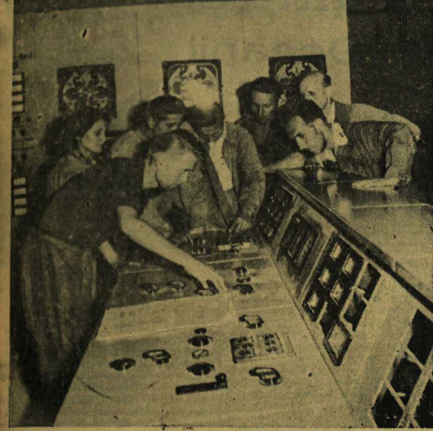
W przeddzień 8 rocznicy wyzwolenia Rumunii uruchomione zostały nowe obiekty przemysłowe. Tak uczył naród rumuński Święto Wyzwolenia i Konstytucji. Jedną z największych inwestycji jest wielka elektrownia im. Gheorghiu-Dej'a. Na zdjęciu: kabina kierownicza turbogeneratorskiej elektrowni.
