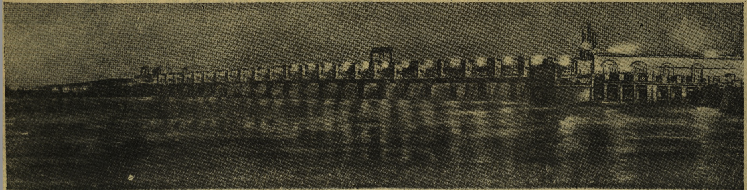
27 lin cały Związek Radziecki obchodził uroczystość oddania do użytku pierwszej z wielkich stalinowskich budowli komunizmu — Kanału Wołga — Don. Na zdjęciu: zapora Cymlańskiej elektrowni wodnej. (Patrz artykuł „Otwarcie Kanału” oraz opowiadanie Polewoja na str. 3).
