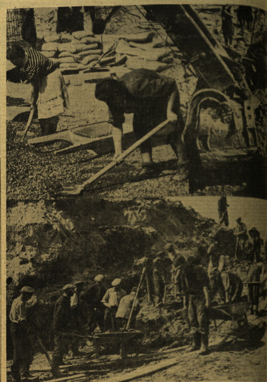
O wspaniałym czynie społecznym społeczeństwa Kielecczyzny, które nie pomaga budowniczym cementowni w Wierzbicy w realizacji pięknego dzieła — budowlę planu sześciokątnego w naszym województwie — pisaliśmy obszernie w jednym z poprzednich numerów „Życia”. Na zdjęciu przedstawiają zatrudnionych przy budowie: robotników, m. cowników umysłowych, kobiety z różnych ośrodków: Radomia, Kielc, Sandomierza itp. przy pracy.
