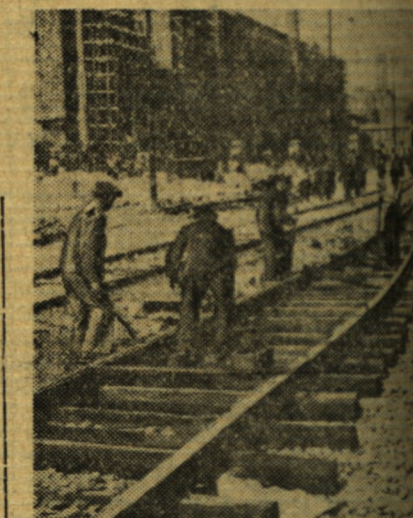
Podczas gdy brygady tramwajarzy układają jeden tor już na stałe, na dwóch pozostałych normalnie odbywa się ruch...
